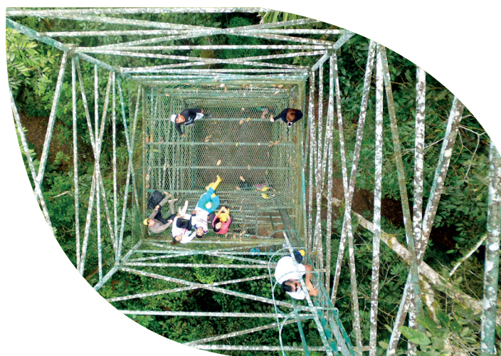
Foto 3. Torre de observación
